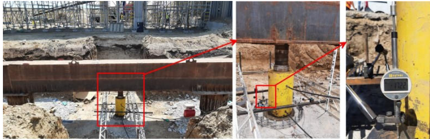
Slika 7. Konstrukcija sistema za opit probnog opterećenja šipa
